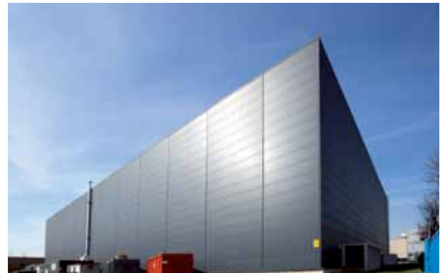
Centro logistica in località Cernusco sul Naviglio Logistic centre in Cernusco sul Naviglio
